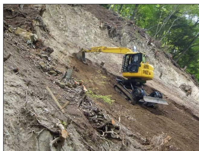
作業中（法面掘削）
