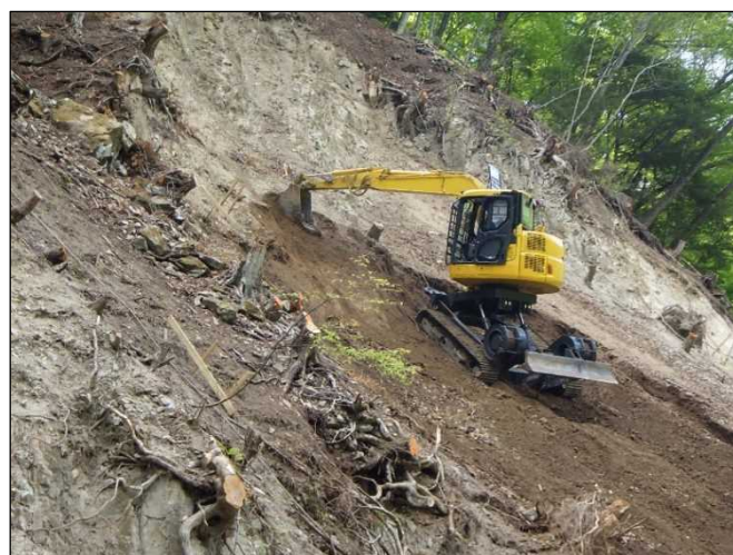
作業中（法面掘削）
