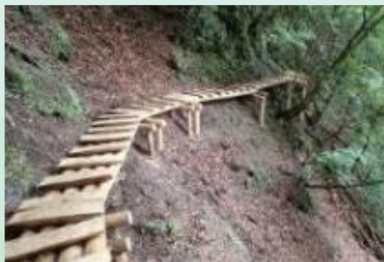
▲栈橋の設置状況
