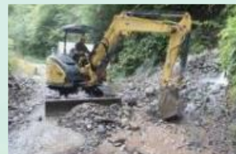
▲土砂除去作業
