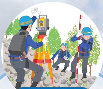
危険な現場作業
