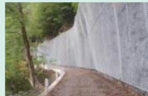
▲安全施設の設置
