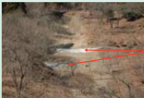
▲土留工による復旧
