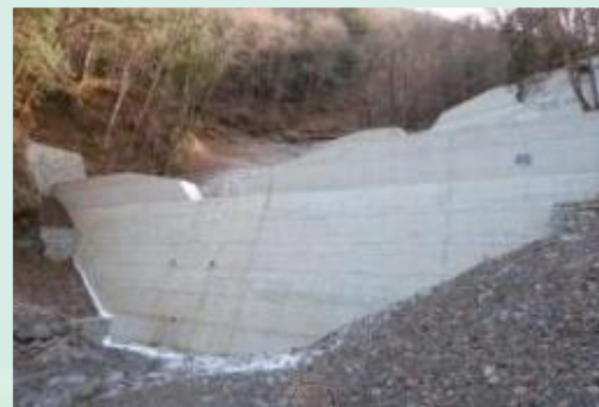
▲治山ダムの設置
