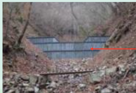
▲治山ダムによる復旧
