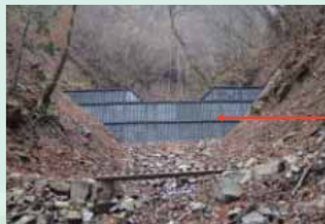
▲治山ダムによる復旧
