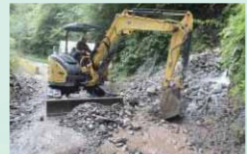
▲土砂除去作業
