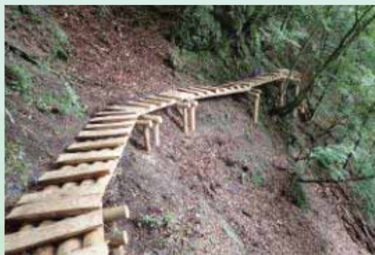
▲栈橋の設置状況
