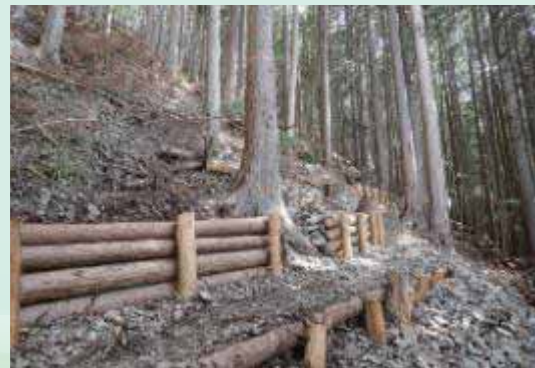
▲木柵の設置状況
