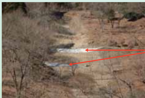
▲土留工による復旧
