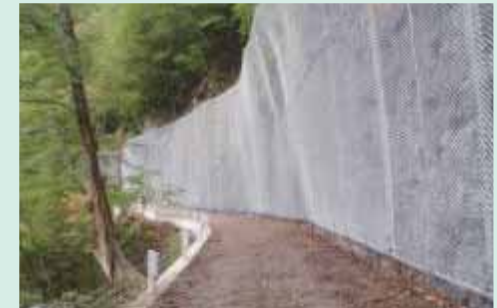
▲安全施設の設置
