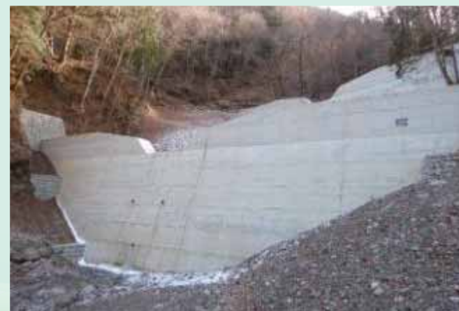
▲治山ダムの設置
