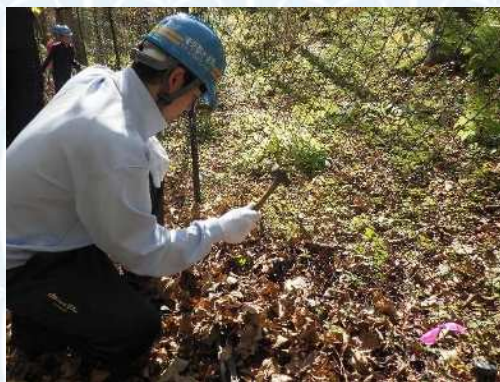
柵の下からシカが入り込まないようにアンカーを増やして設置しました。
