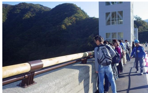
午後は小河内ダムの堤体見学などを行いました
