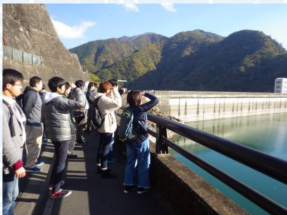
午後は小河内ダムの堤体見学などを行いました
