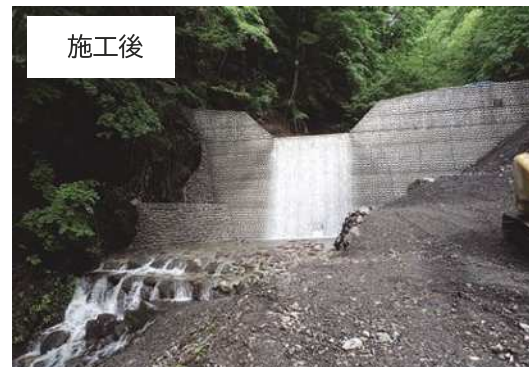
谷止工破損箇所の改修による治山施設の機能回復
