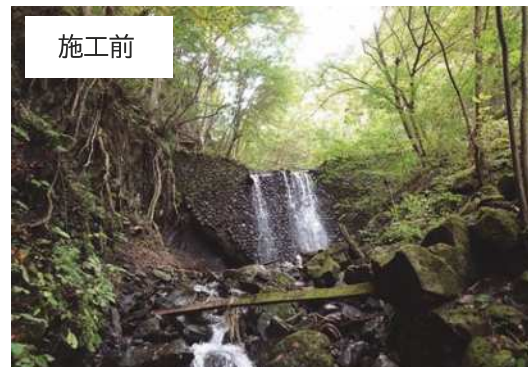
谷止工破損箇所の改修による治山施設の機能回復
