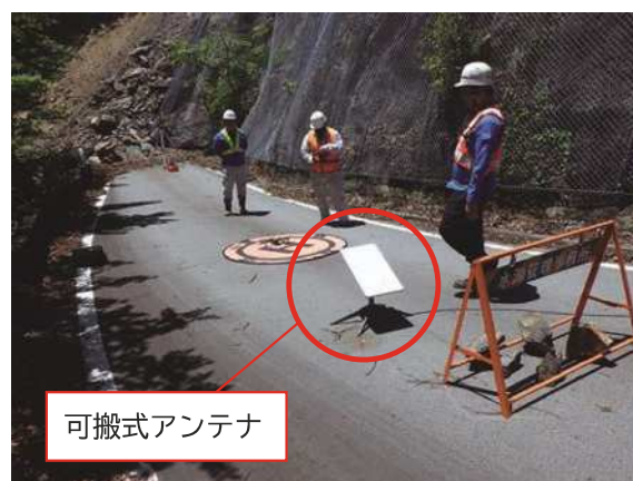
可搬式アンテナの設置による通信基盤の構築
