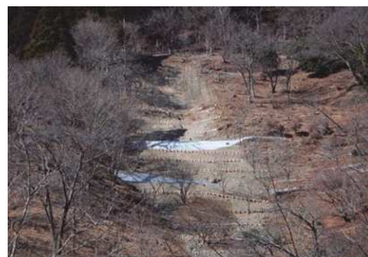
土留工による崩壊地の復旧
