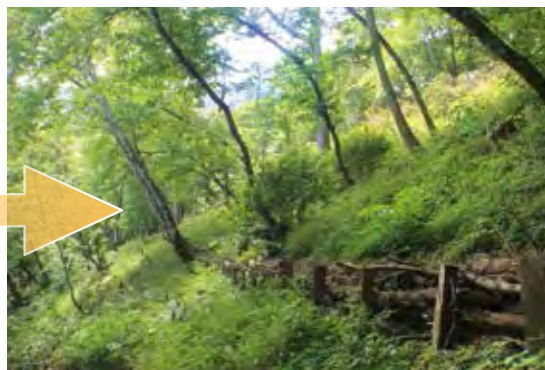
効果検証箇所（施工1年後）（植生が回復）
