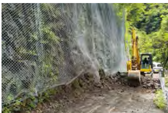
土砂片付け作業
