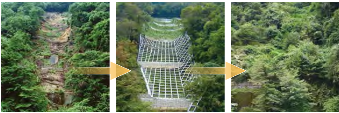
山腹崩壊地の復旧（施工前）
