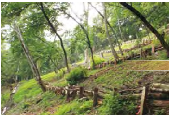
効果検証箇所（施工直後）（間伐の実施及び木柵・侵入防止柵の設置）
