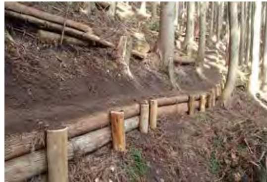
歩道の設置状況
