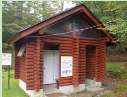
笠取小屋付近のバイオトイレ
