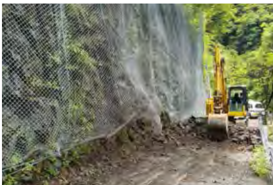
土砂片付け作業
