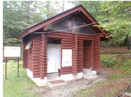
現在のバイオトイレ(笠取小屋)
