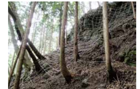
予防治山工事による落石の予防
